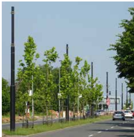
Připravené sloupořadí v červnu 2023 na horní části ulice Evropské. Zde jsou použity sloupy uprostřed pásu s výložníky. Foto: Jiří Šimůnek
