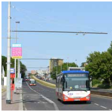
Autobus Iveco Crossway LINE 12LE ev. č. 1252 dopravce POHL Kladno projíždí v květnu 2023 po ulici Evropské pod připraveným výložníkem se závěsy pro budoucí trolejbusovou trať linky č. 59. Foto: Libor Hinčiča
