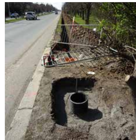
Pohled na rozestavěnou trolejbusovou trať nad Divokou Šárkou. V popředí je základ pro samostatné veřejné osvětlení, za ním je vidět větší oranžový základ (je přes něj položena zábrana) pro trolejbusový stožár a dále je vidět výkop pro kabelovou trasu. Foto: Jiří Šimůnek
