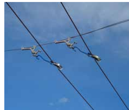
Detail provizorního zavešení trolejového vedení během výstavby. Tento snímek pochází konkrétně z listopadu 2023 z horní části ulice Evropské. Foto: Jiří Šimůnek
