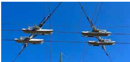
Křížení s tramvajovou trolejí u vovozny Vokovice. Konstrukce umožňuje jízdu tramvají i trolejbusů pod proudem. Foto: DPP
