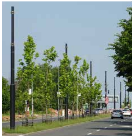
Připravené sloupořadí v červnu 2023 na horní části ulice Evropské. Zde jsou použity sloupy uprostřed pásu s výložníky. Foto: Jiří Šimůnek
