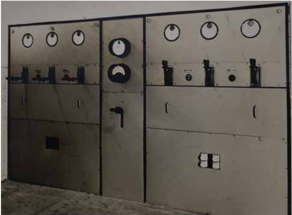
Pohled na usměrňovače z ČKD instalované v měničárně Pršténě ve Zlíně v roce 1954. Sbírká: Libor Hinčica
