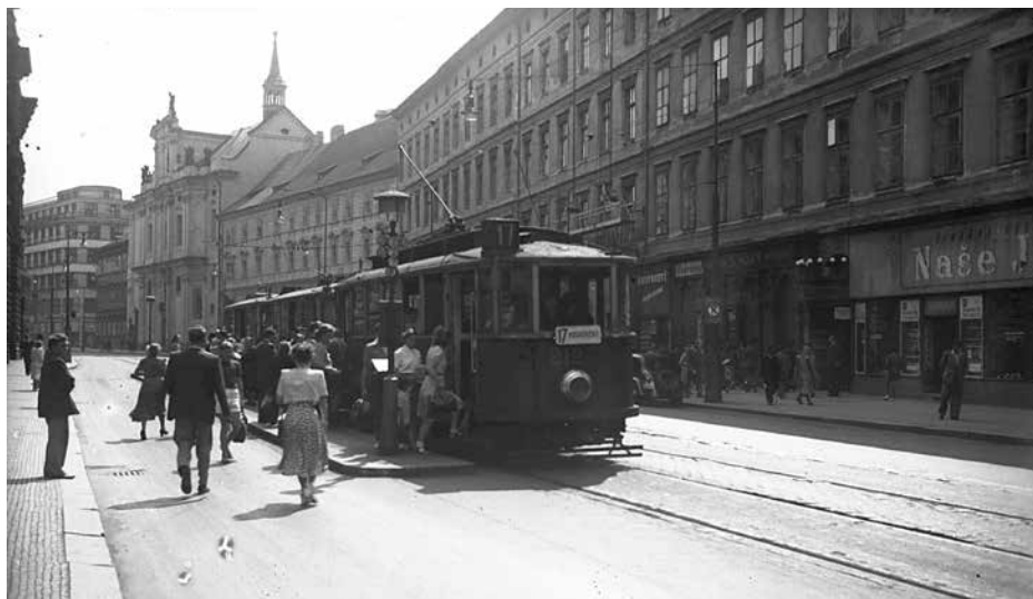
Na Národní třídě v roce 1953 zachycená souprava vedená motorovým vozem ev. č. 2123 z roku 1928. Ačkoli Praha hodala nakupovat ve velkém množství nové tramvaje koncepce PCC, nakonec musela ve stavu nadále udržovat staré dvounapravové vozy. Ty měly výrazně nižší spotřebu i jednodušší údržbu. Sběrka: Archiv DPP
