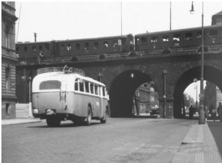
Linkový autobus Škoda 706 RO na Křižíkově ulici v Praze-Karlíně míří pod oblouky Negrelliho viaduktu. Křižíkova ulice tehdy byla fakticky výpadovkou z Prahy a dvojice oblouků zde komplikovala provoz. Proto došlo k jejich zbourání a v roce 1955 byl do provozu uveden nový most z předpjatého betonu (v případě užití na železnici šlo o premiéru využití této technologie). Dál ovšem původní oblouky zůstaly zachovány a nedaleko místa pořízené fotografie se počítalo s tím, že by mohly být dva z nich využity pro ukrytí technologie měnirny „Karlín“. Sbirka: Archiv SUDOP Praha
