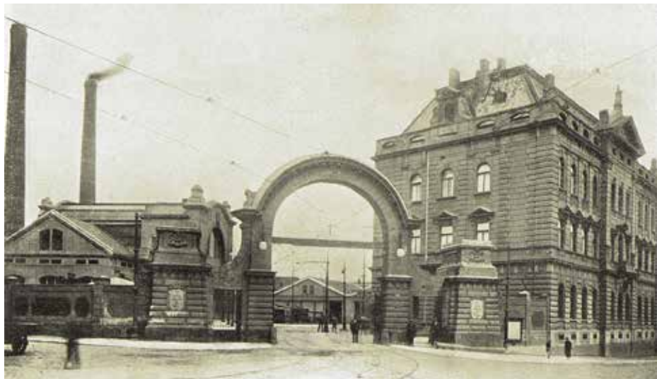
Elektrárna v Praze-Holešovicích byla nejen dílem ryzem technickým, ale i architektonicky zajímavým. Dodnes existující části jsou památkově chráněny, nicméně impozantní vjezd do areálu, za nímž jde vidět hala tramvajové vozovny Elektrických podniků, je již minulostí. Repro z časopisu Český svět
