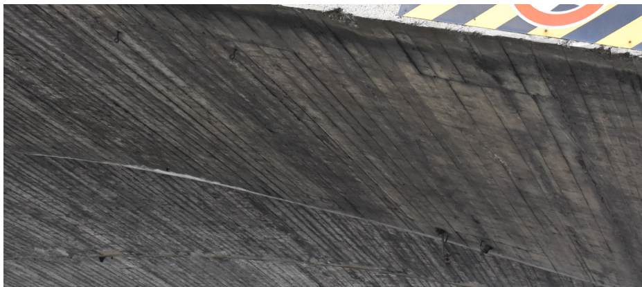
Pozůstatky po upevnění trolejového vedení na klenbě Branického mostu. © Libor Hincica 2022
