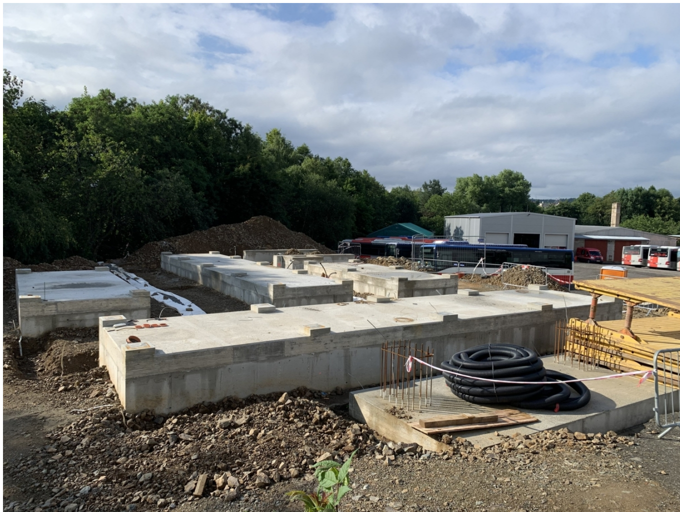
Rozestavěná plnička a elektrolyzátor v Mníšku pod Brdy v sousedství areálu společnosti Martin Uher. (zdroj: facebook Petra Boreckého)
