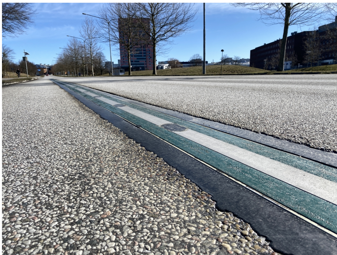
Pohled na detail napájecího pásu, jenž byl zarovnaný do úrovně povrchu vozovky. (foto: EVolution Road)
