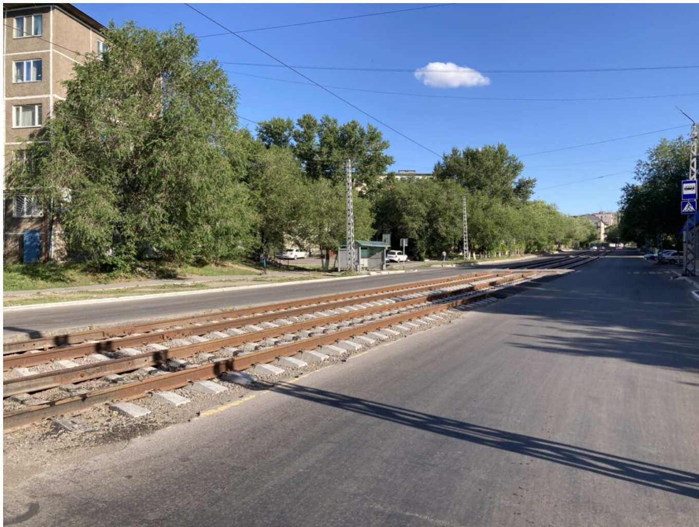
Opravená trať nedaleko centra nového města. (foto: -vh-)
