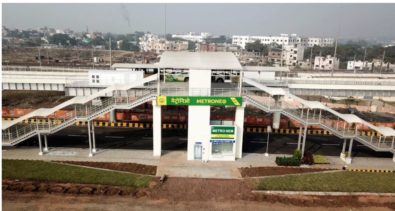
Čelní pohled. (foto: Metro Rail Today)
