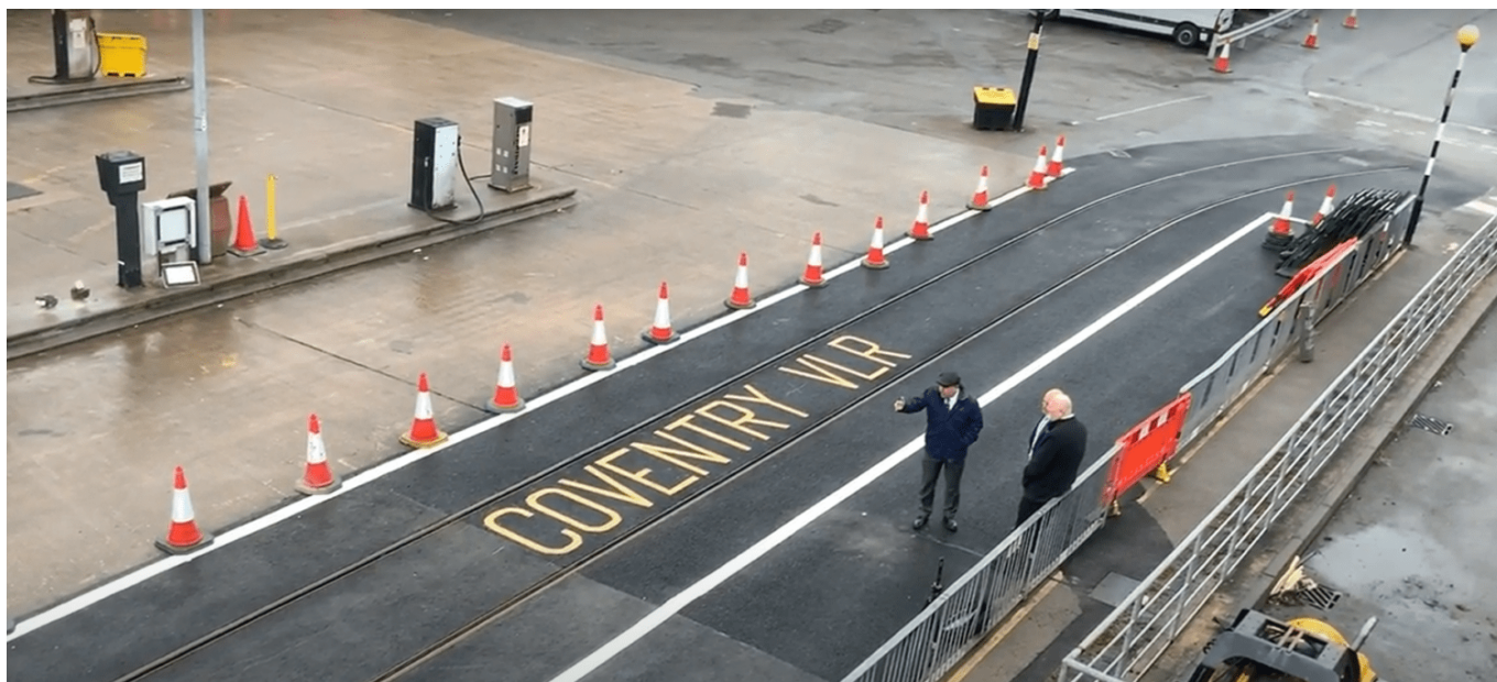
Pohled na dokončený kousek trati z předchozího snímku o délce pár desítek metrů.(zdroj: Coventry City Council)
