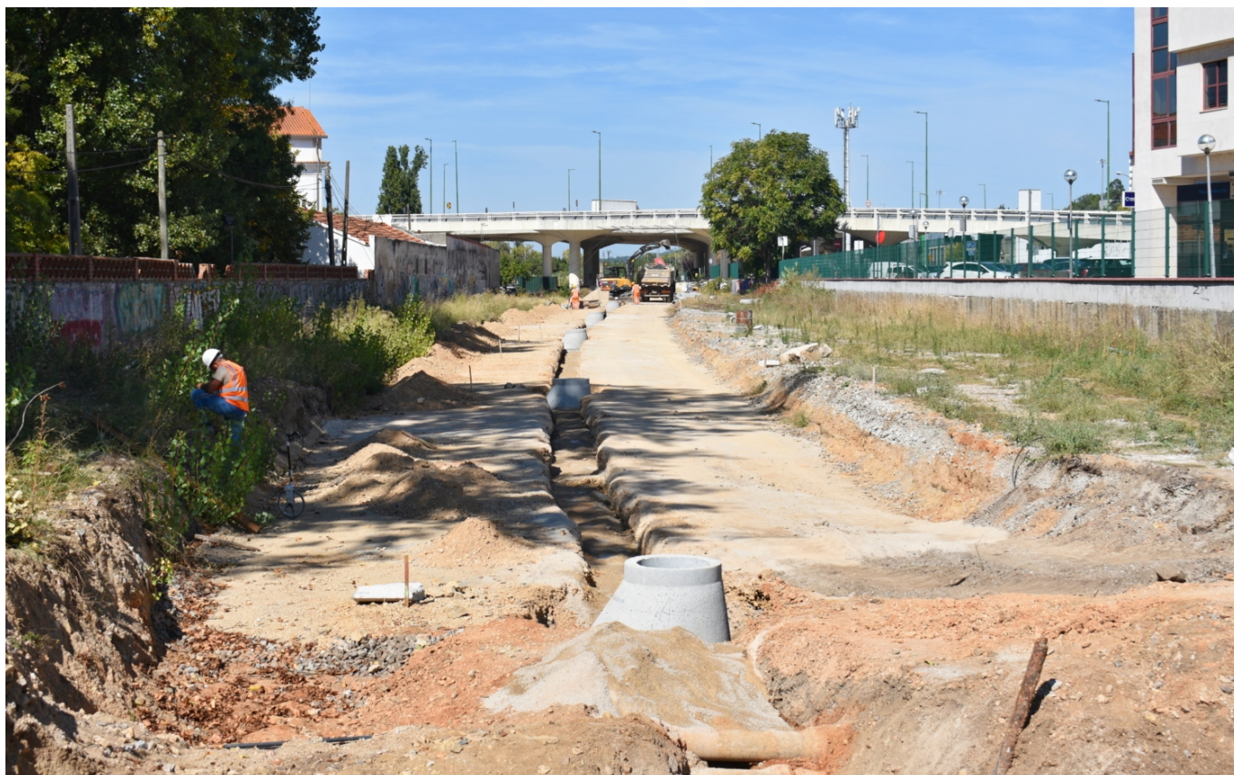
Rozestavěné těleso BRT koridoru v úseku mezi Coimbra-B a Coimbra-A v říjnu 2025. (foto: Matěj Stach)
