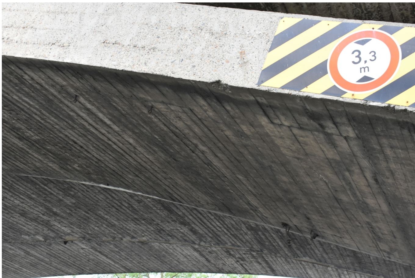
Pozůstatky po upevnění trolejového vedení na klenbě Branického mostu. (foto: Libor Hinčica)
