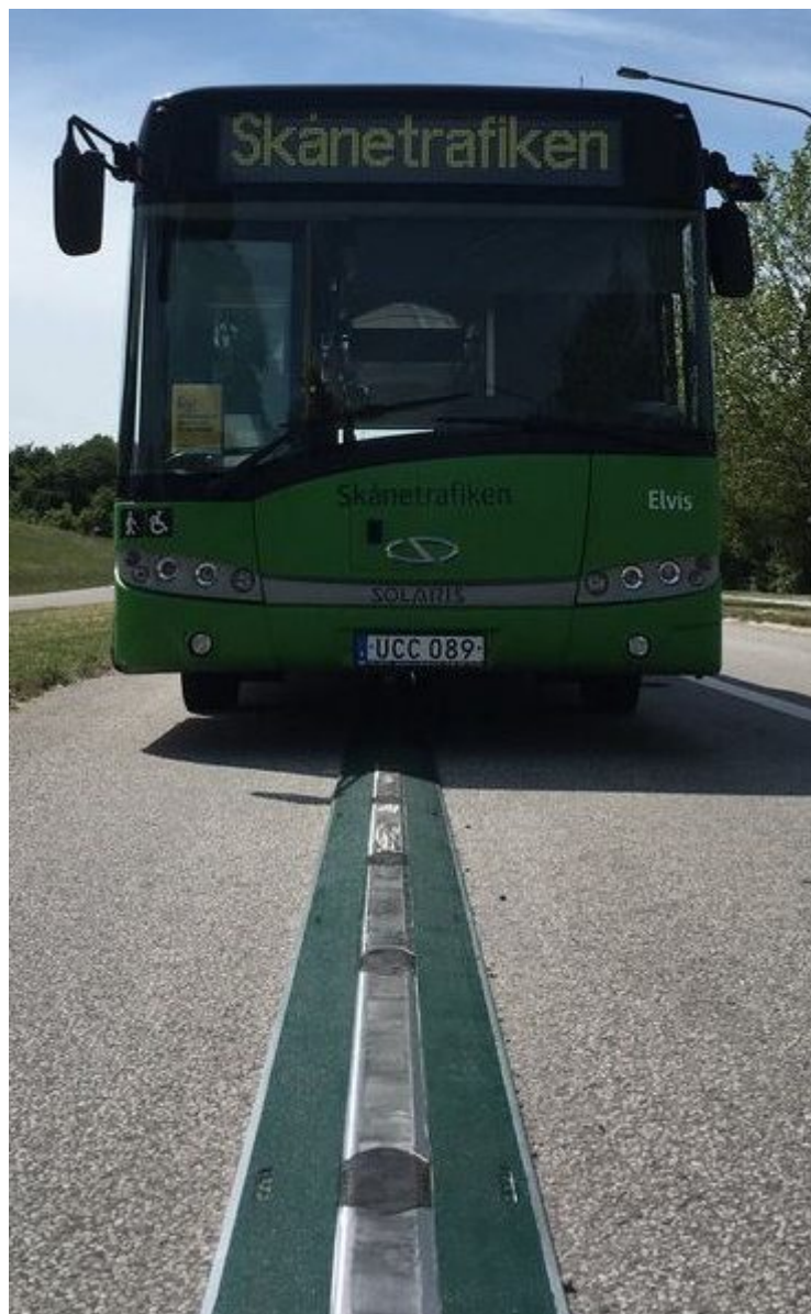
Detail zkušební části elektrické silnice v Lundu. Vybudována je na úseku dlouhém 1 km v rámci vyhrazeného buspruhu. (foto: EVolution Road)
