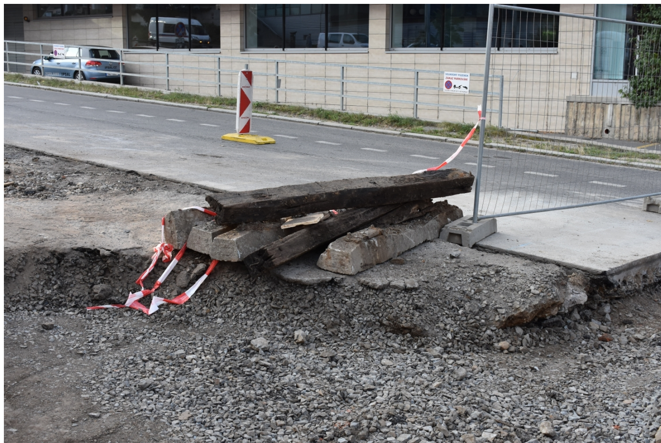
Vytěžené prazce z původní tramvajové trati používané v letech 1970-74. (foto: Libor Hinčica)
