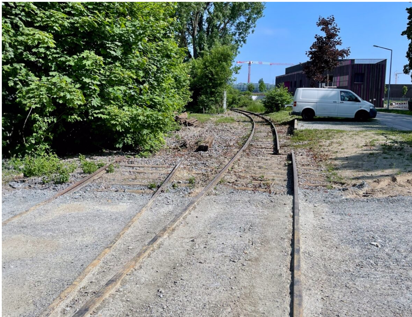
Prozatímní ukončení trati v ulici Guerickstraße, stav v květnu 2022. V plánu je přerozchodovat i výhybku, na které se autor v době pořízení snímku nacházel. (foto: Jan Šimek)
