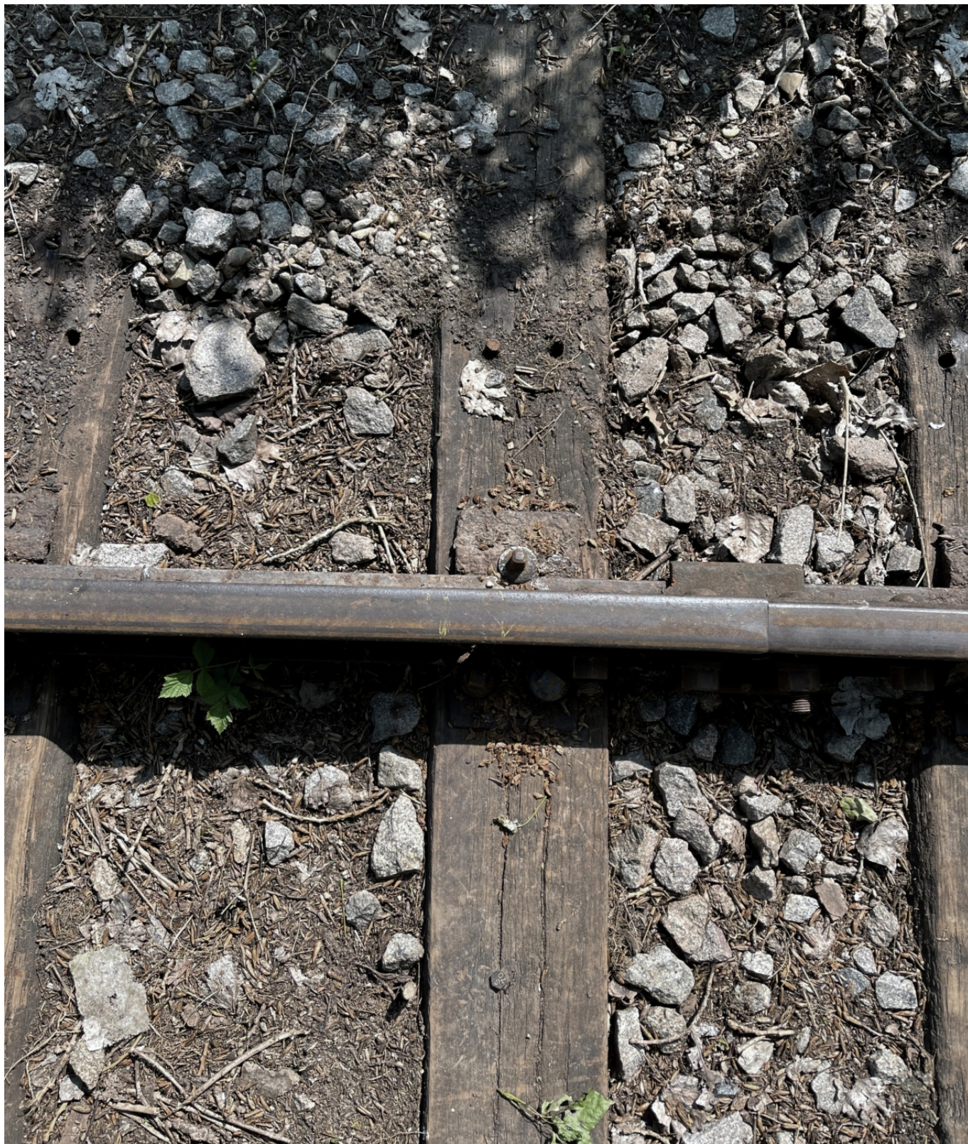
Kolejnice a prvky jejich uchycení z roku 1884. Pražce zůstaly v tomto případě ležet na svém místě. Na fotce je dobře patrná původní o 43,5 cm širší stopa. (foto: Jan Šimek)
