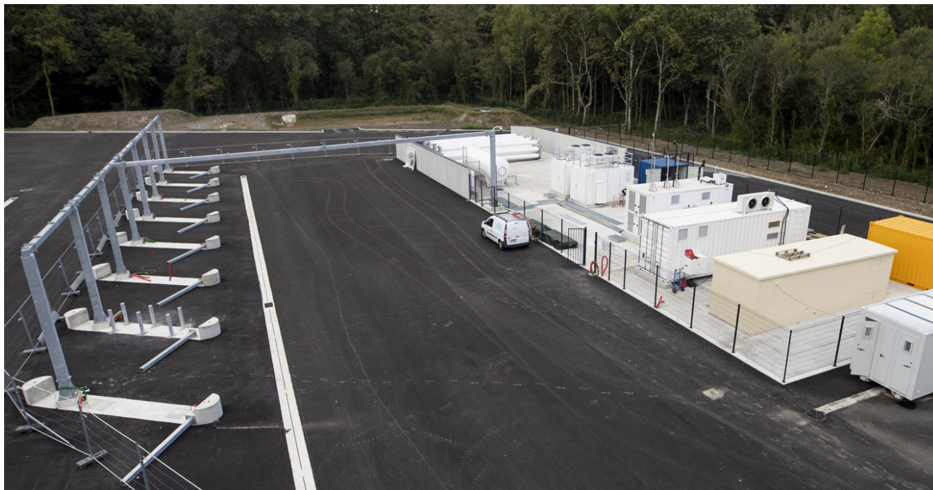
Pohled na připravenou stanici pro výrobu vodíku a odstavná stání. Stanice zvládne pojmout až 800 kg vodíku, vyrobit má denně až 263 kg. (foto: Ville de Pau)
