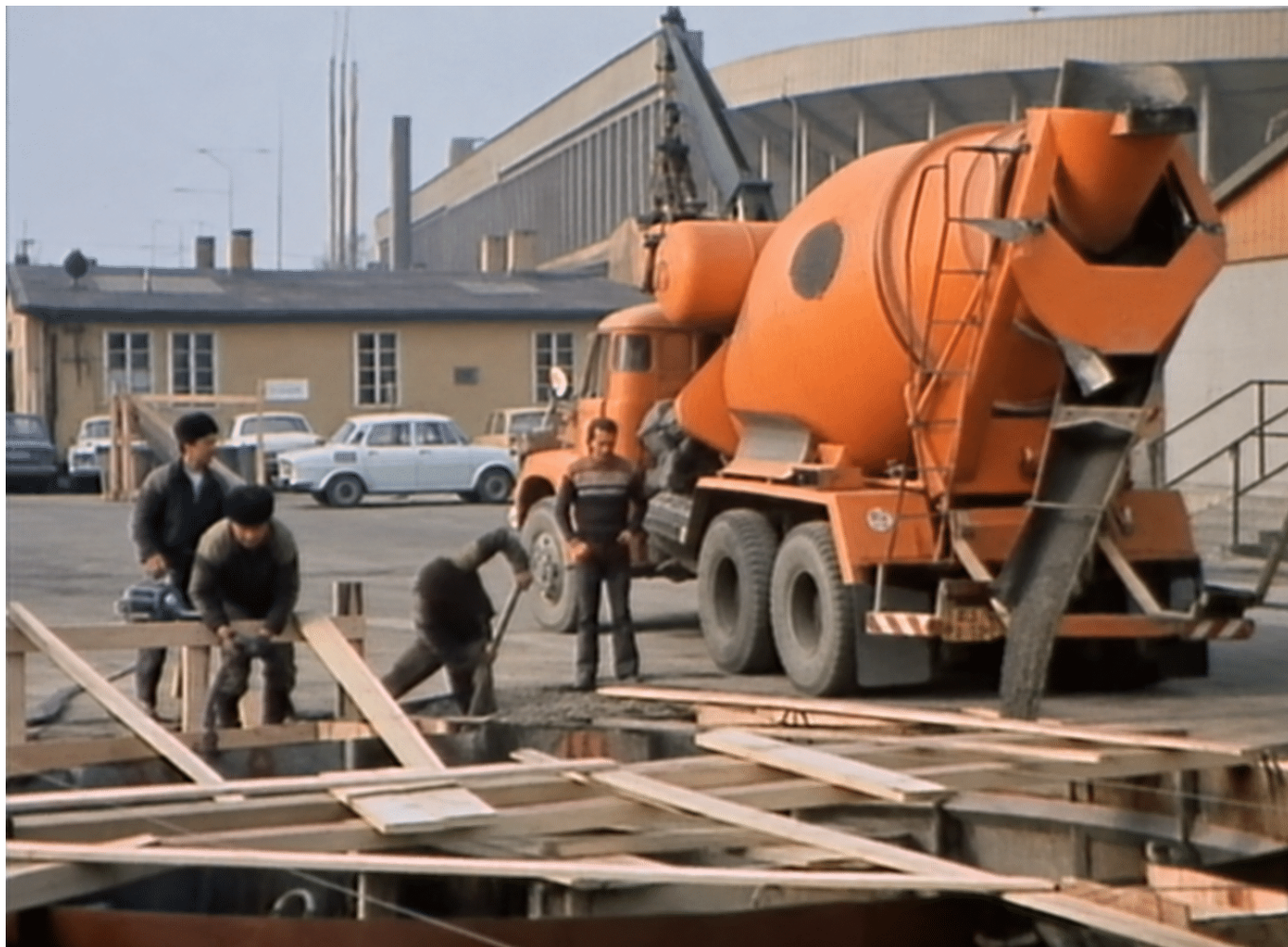
Záběr z dobové reportáže Československé televize ukazující počátek ražby průzkumné štoly Strahovského tunelu v únoru roku 1980. (zdroj: printscreen z reportáže ČST)
