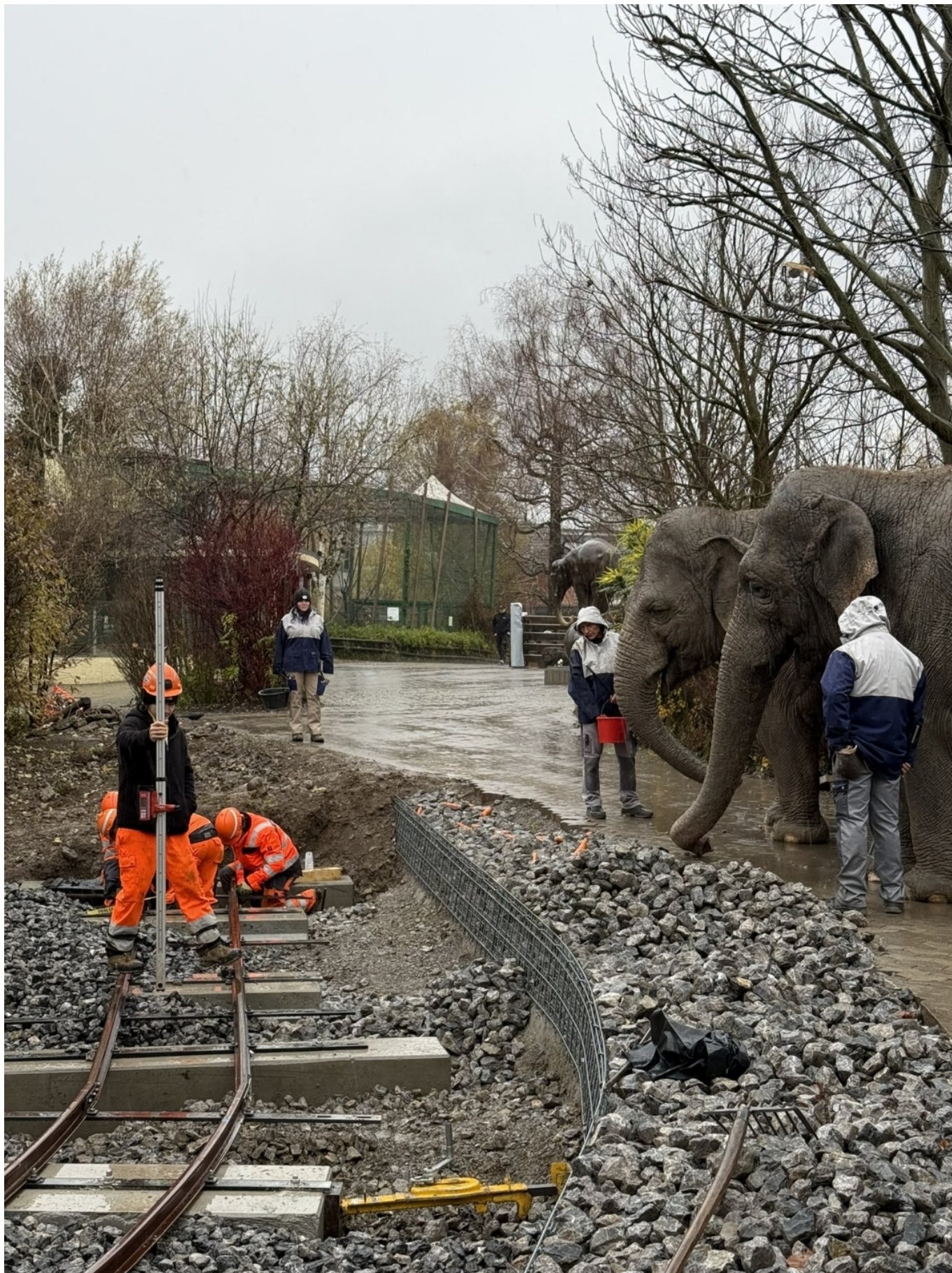
Rekonstrukce „tramvajové“ trati o rozchodu 600 mm se odehrává v režii učňů pracujících v rámci studia u Schweizerische Südostbahn. (foto: Stadler)
