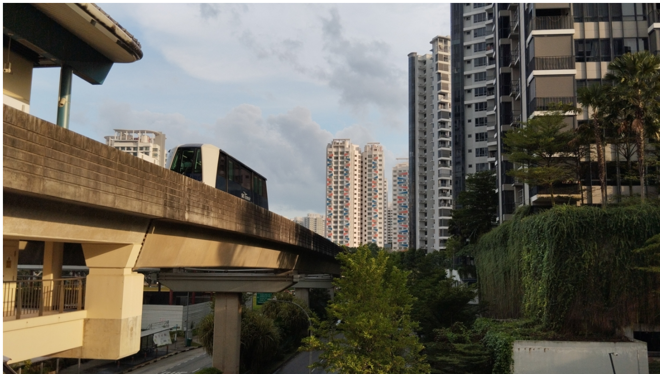
Pohled na mostní konstrukci pro LRT vinoucí se mezi bytovou zástavbou na severním předměstí Singapuru. (foto: Lukáš Vrána)
