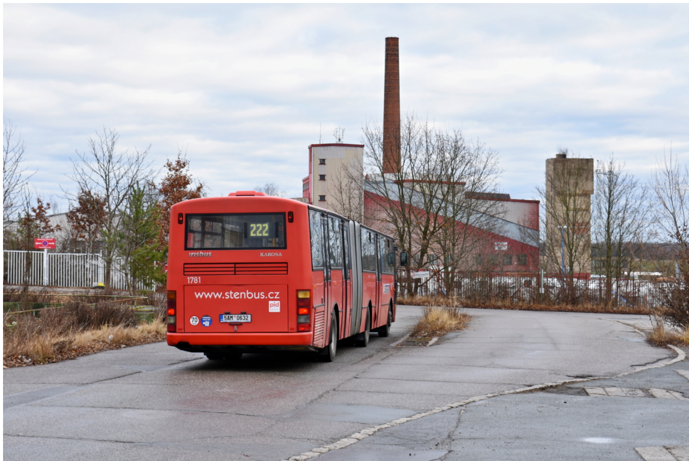
Pod 64 metrů vysokým komínem bývalé teplárny a elektrárny v běchovickém Areálu výzkumných ústavů projíždí Karosa B 961E.1970 ev. č. 1781 převlečená na linku 222. (foto: Matěj Stach)
