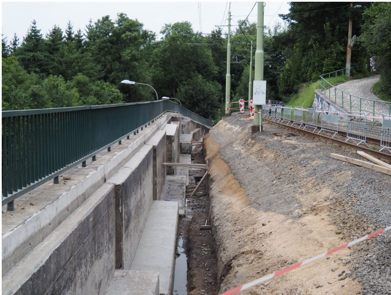
Opravu prodělala i vnitřní strana opěrné stěny pod Novou Rudou, při které muselo být odstraněno těleso přilehlé koleje. (19. srpna 2021; foto: Zdeněk Mazánek)
