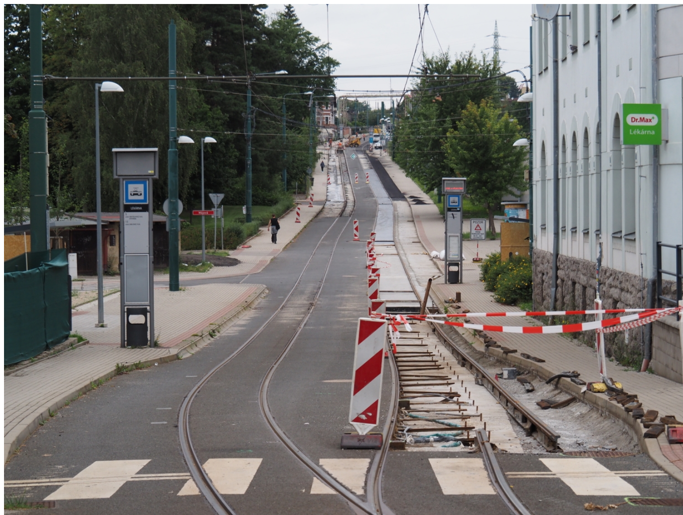
Úpravy změny rozchodu kolejí v ulici U Sila mezi zastávkami Lékařna a Pivovarská (19. srpna 2021; foto: Zdeněk Mazánek)
