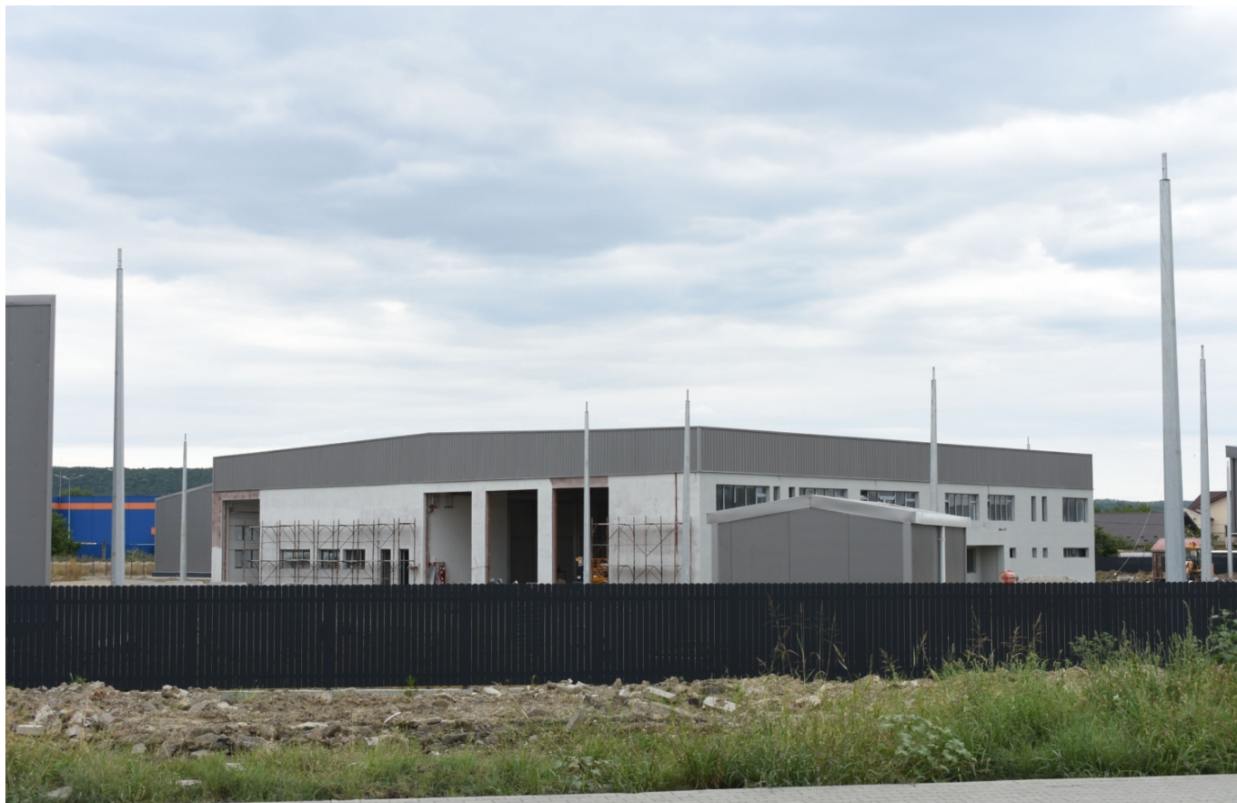
Ještě jeden pohled na stále pouze rozpracovanou vozovnu. (foto: Libor Hinčica)
