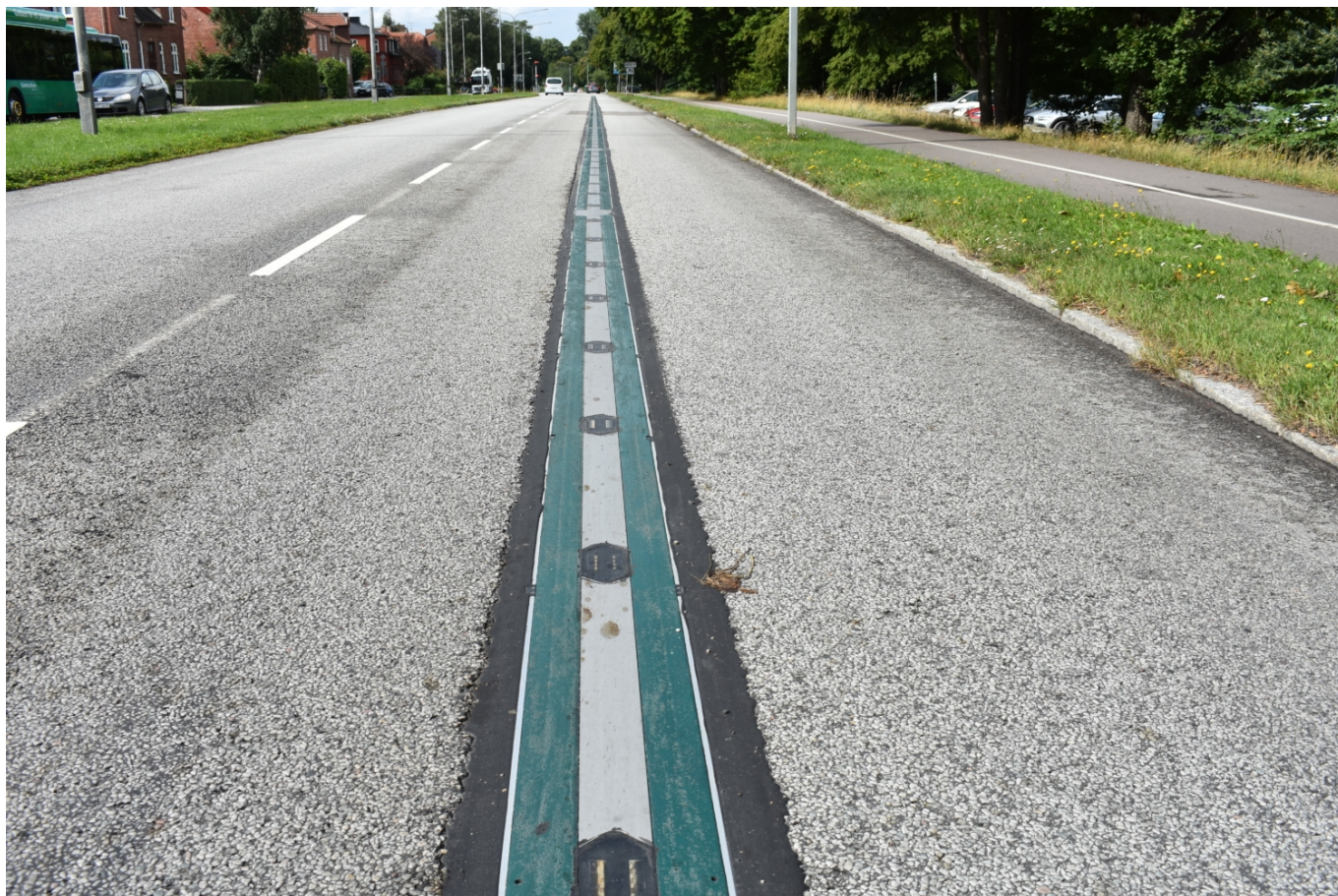
Zapuštěný napájecí pás ve vozovce. (foto: Libor Hinčica)
