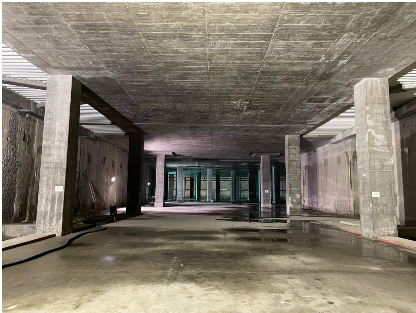
Budoucí tunel pro druhou etapu tramvajové trati vybudovaný s předstihem v rámci rekonstrukce železniční stanice. (foto: Tramwaje Warszawskie)
