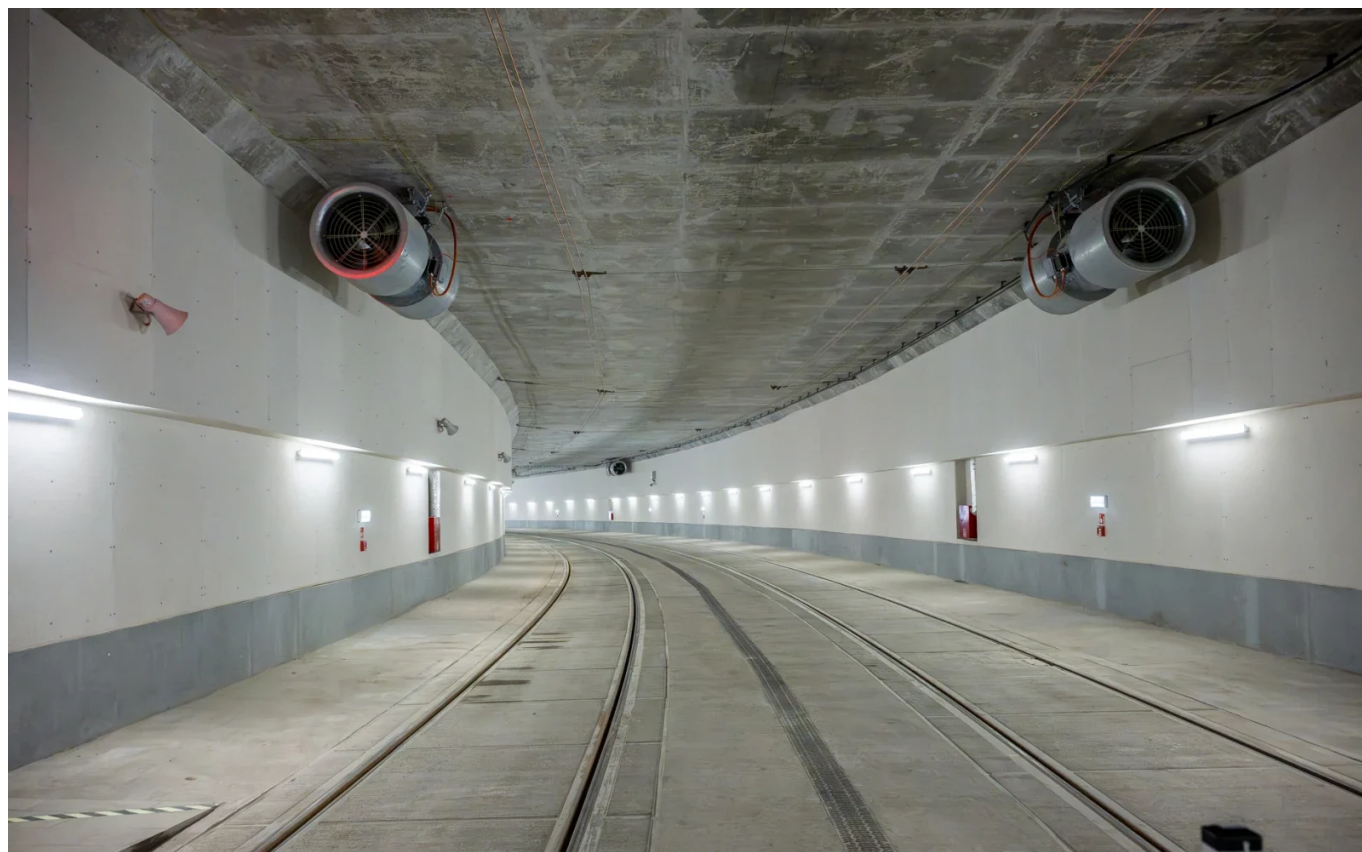
Tunel byl vybudován metodou cut & cover. (foto: Piotr Wojnarowski – kancelář primátora města Krakov)
