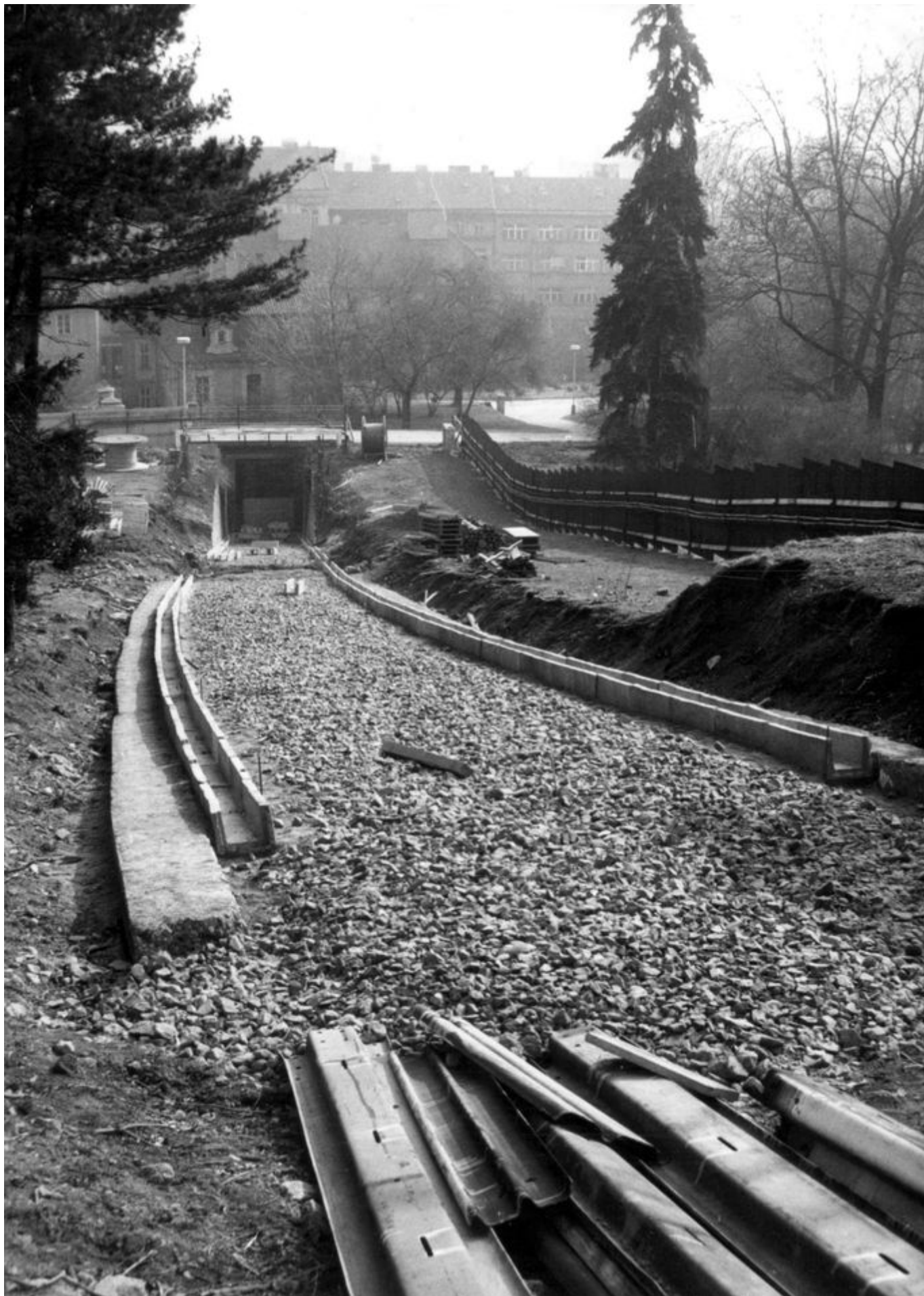
Rozestavěné těleso lanové dráhy na Petřín. Jako první bylo předáno staveniště ve spodní části lanové
