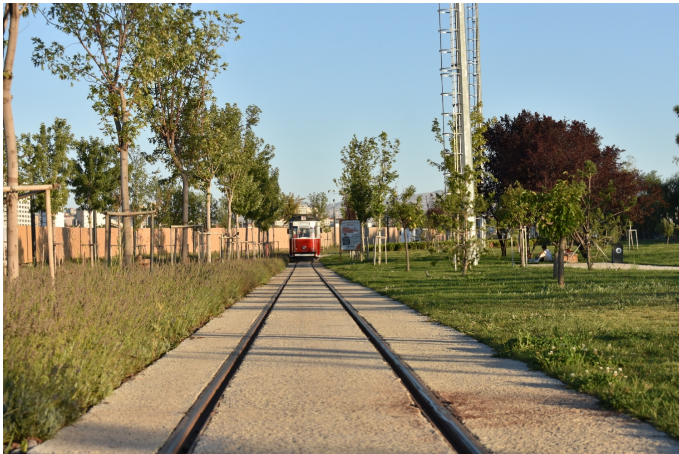
Detail provedení tramvajové trati. (foto: Libor Hinčica)
