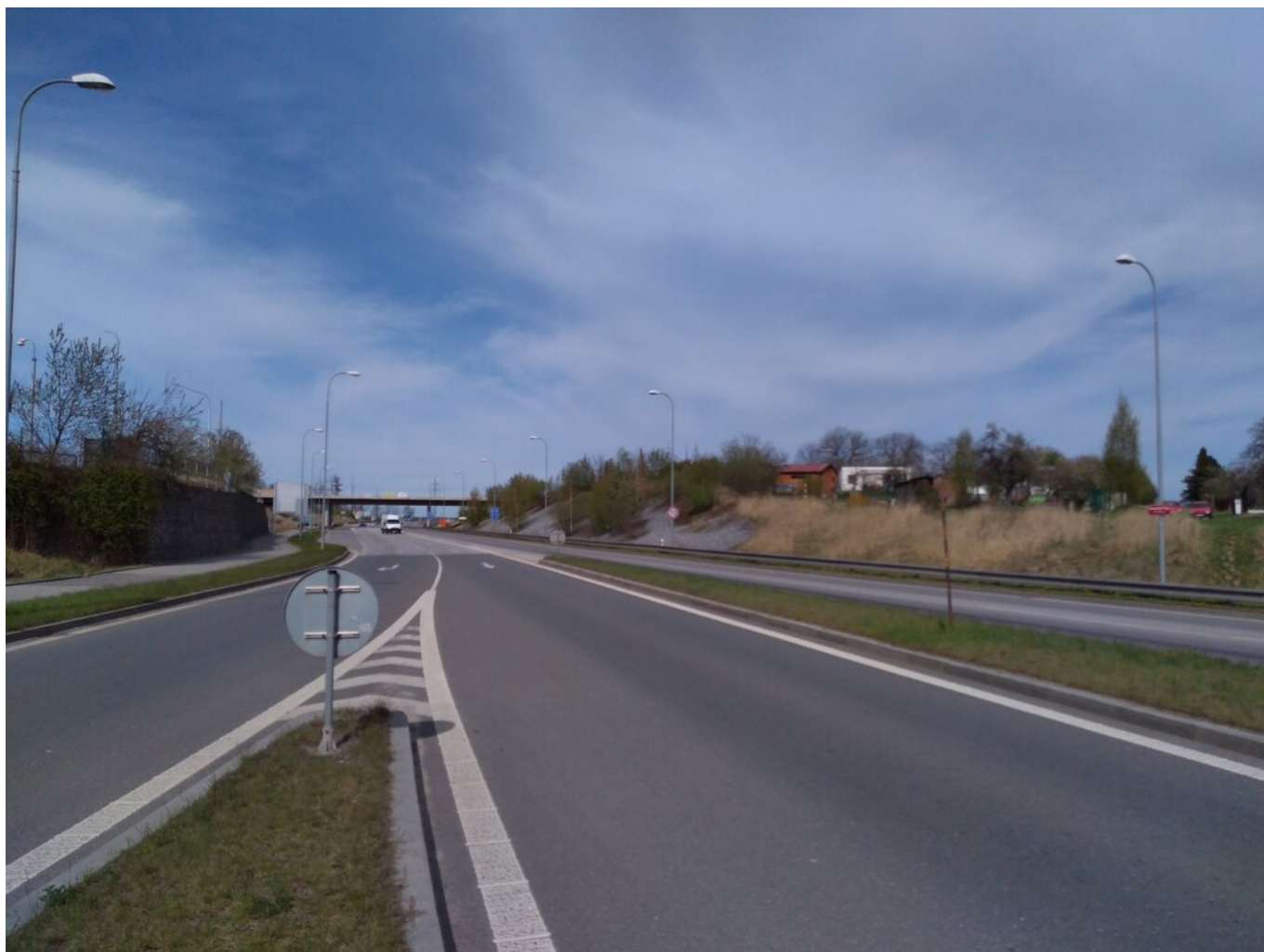
Pohled zpět směrem k vozovně.
