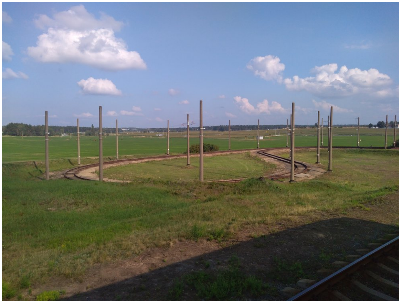
1. nácestná smyčka ve směru k závodu.
