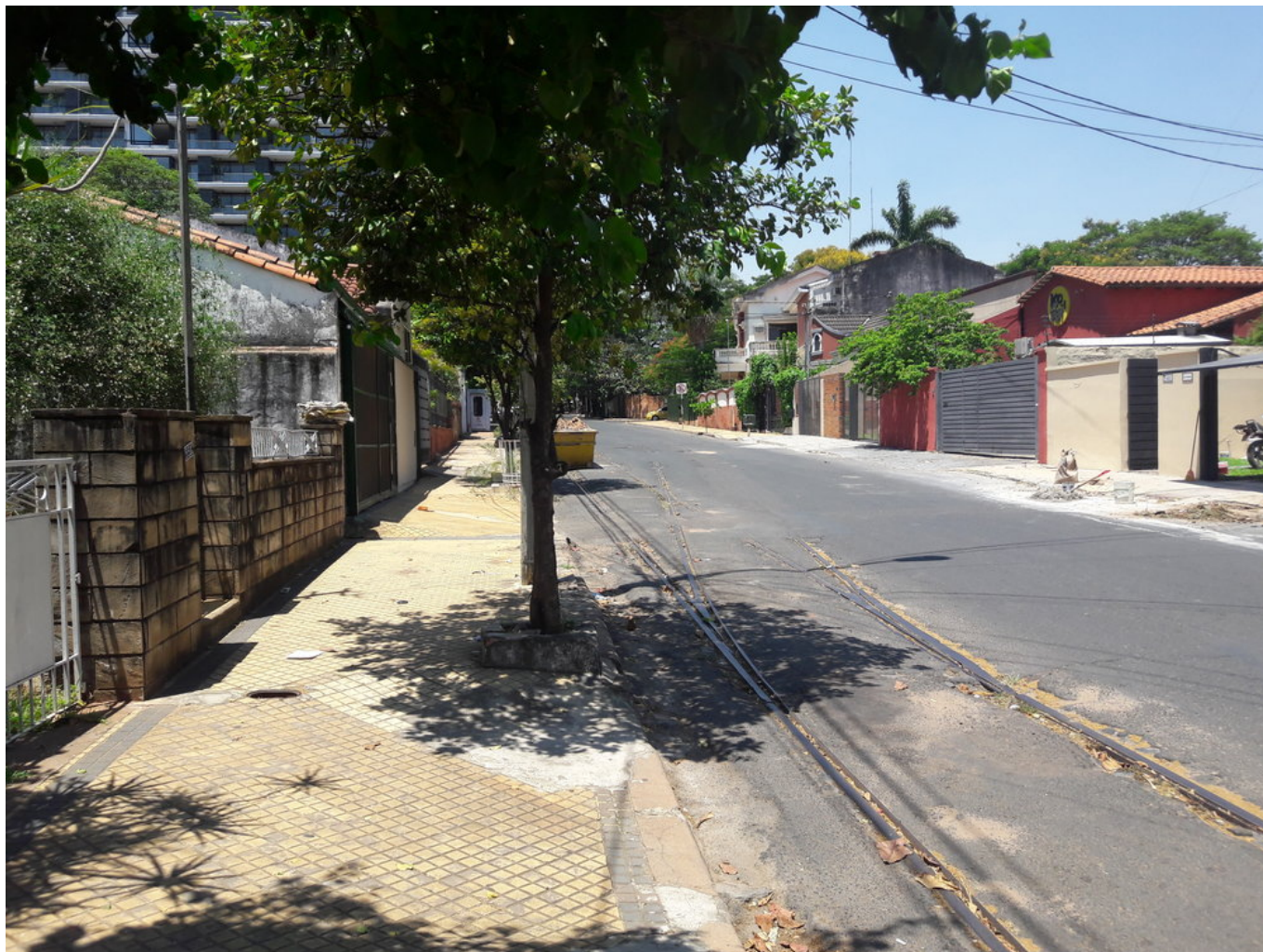
Před výjezdem z ulice Padre Cardozo na ulici España byla výhybna, jak prokazují tento a další snímky.
