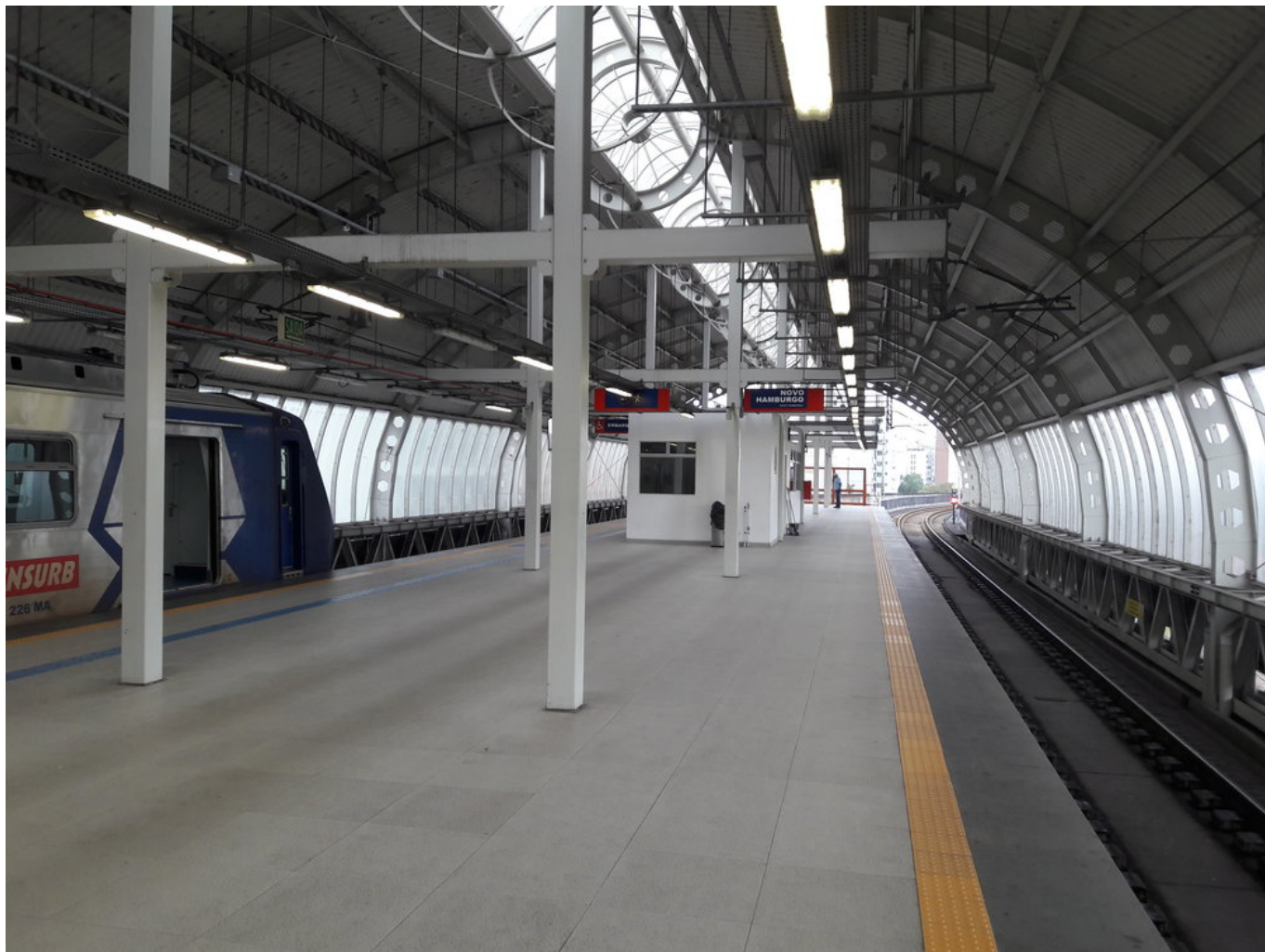
Konečná stanice Novo Hamburgo.
