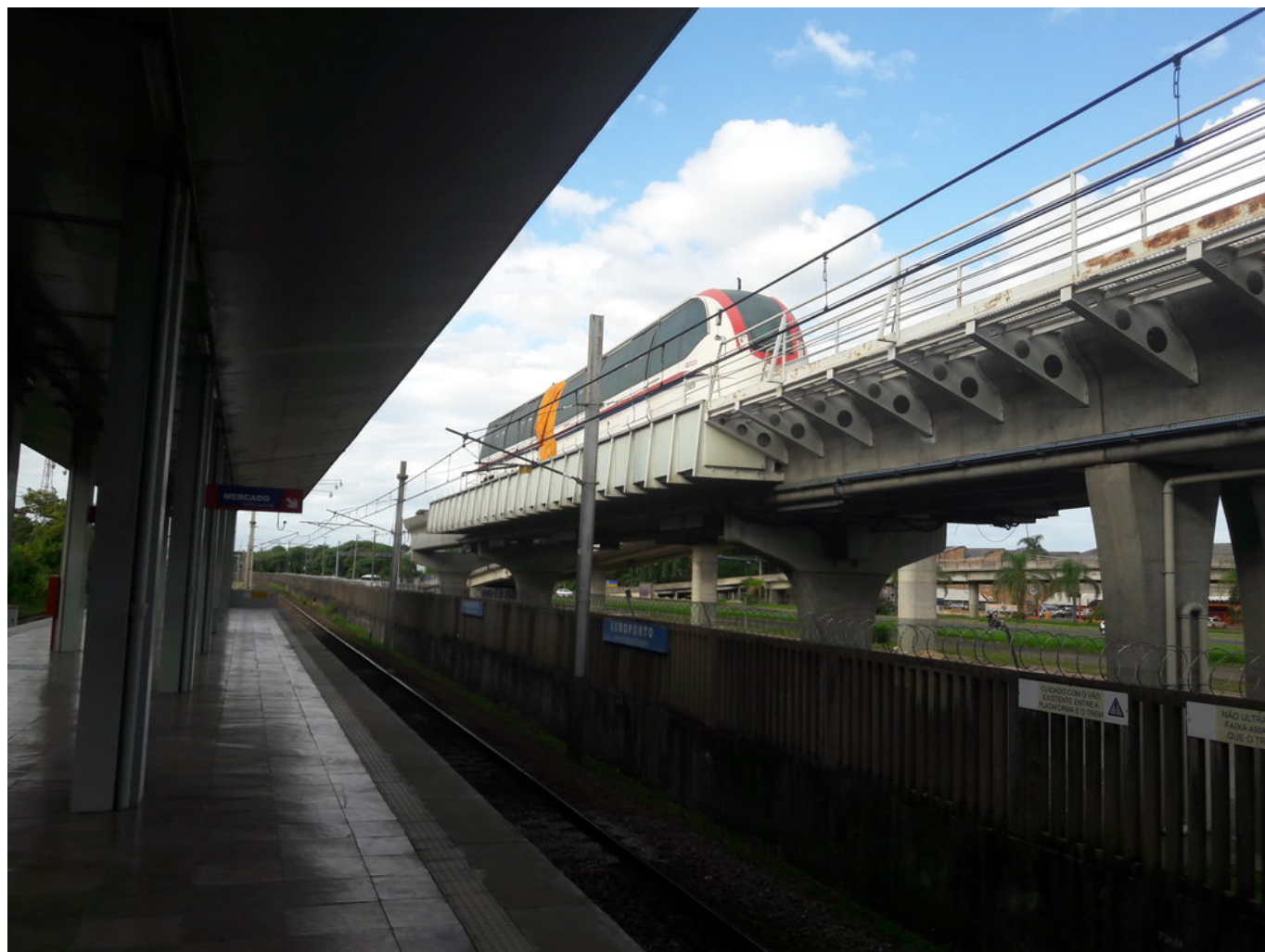
Stanice Aeroporto s nefunkční dvouvozovou jednotkou.
