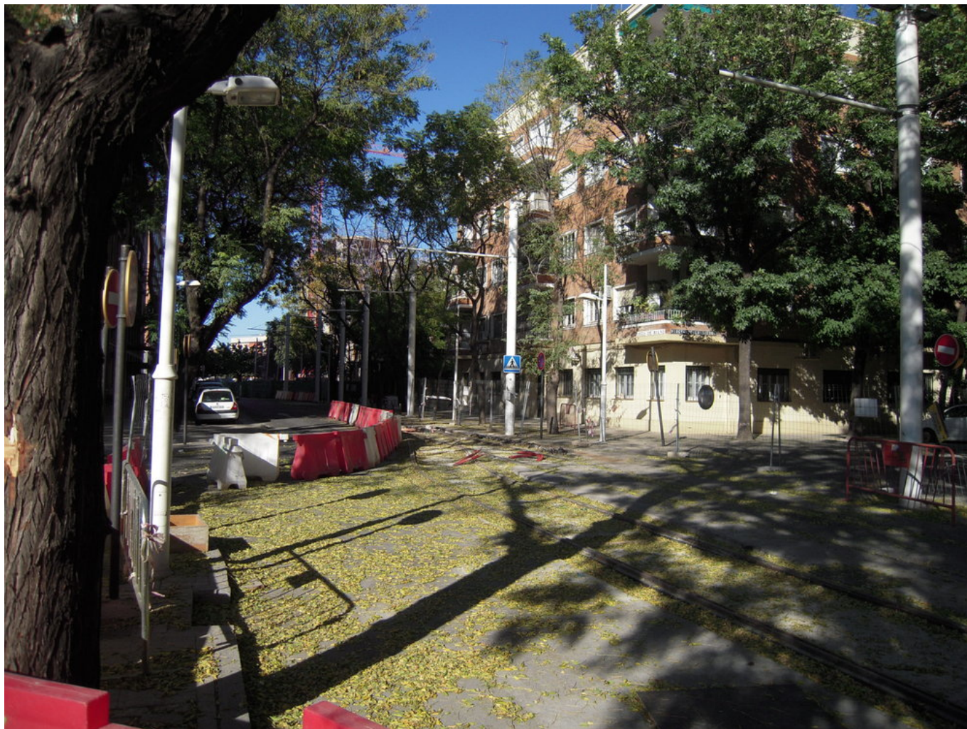
Vozovna na snímcích z roku 2010
